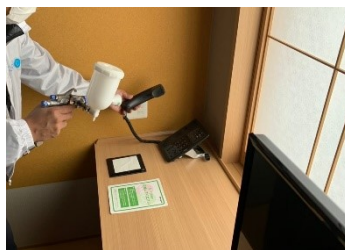
客室の施工(イメージ)
