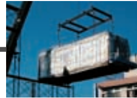
現地ではクレーンで吊上げて据え付けるだけ
